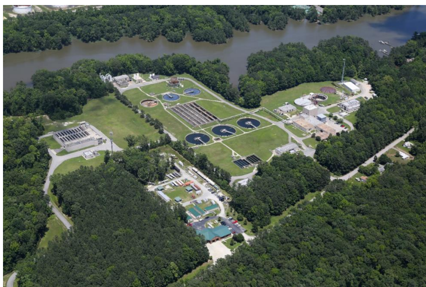
图 7.4 位于弗吉尼亚州西福德的汉普顿路卫生区 (HRSD) 约克河处理厂 (YRTP)
