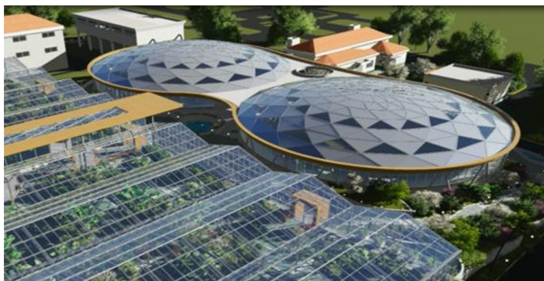
图 17.4 吴淞 WWTF，图片由 Organica Water 提供
